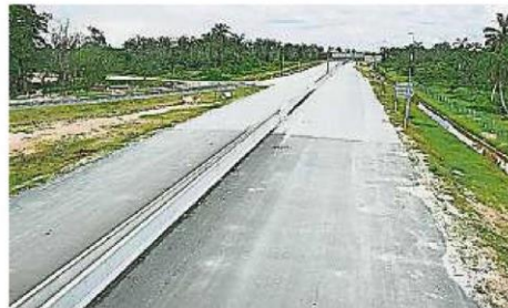
西海岸大道在雪州的施工进度为61.22%。
